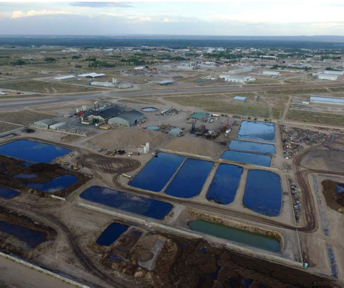
La planta de tratamiento de residuos petroleros Comarsa ubicada en el ejido de la ciudad de Neuquén ocupa 34 hectáreas.
